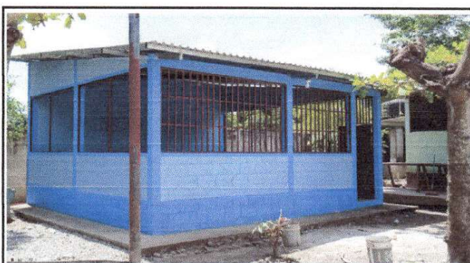
Foto 4: Finalización de colocación de puerta de metal
