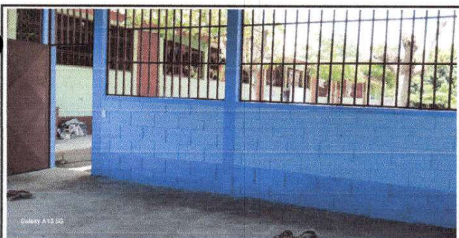
Foto 5: Finalización de construcción de piso de cemento líquido
