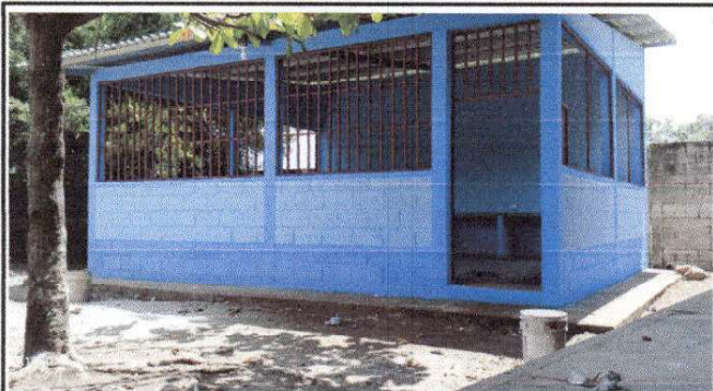
Foto1: Finalización de muro de block
