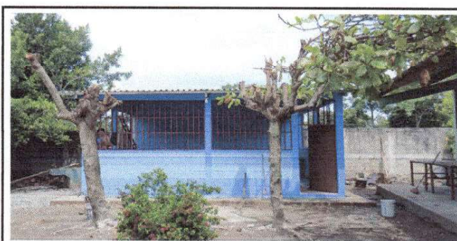
Foto 6: Pintura de interior y exterior finalizada
